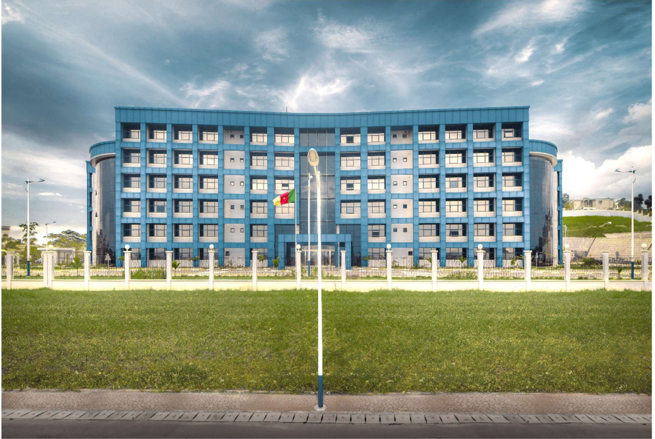
VUE DE FACE DE LA DIRECTION GÉNÉRALE DU FEICOM
